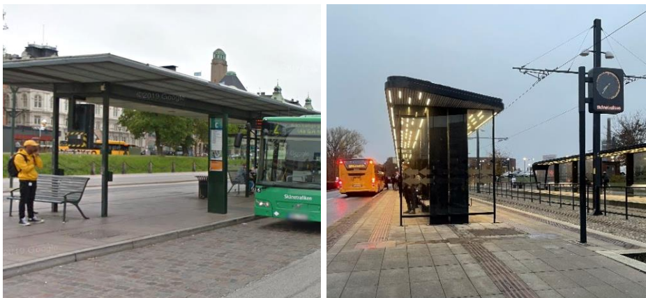
Figur 30 Referensexempel på utformning av hållplatsplattformar från Malmö Central och, Universitetssjukhuset i Lund, där hållplatsen har ett gemensamt tak istället för konventionella väderskydd med bakstycke. Bild: Sweco.
