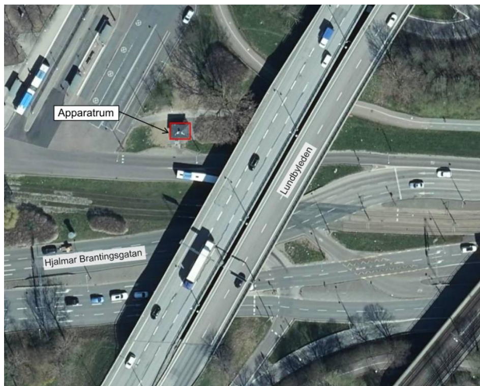
Figur 14 Apparatrum för styrutrustning, mellan Lundbyleden och Hjalmar Brantingsplatsen.
